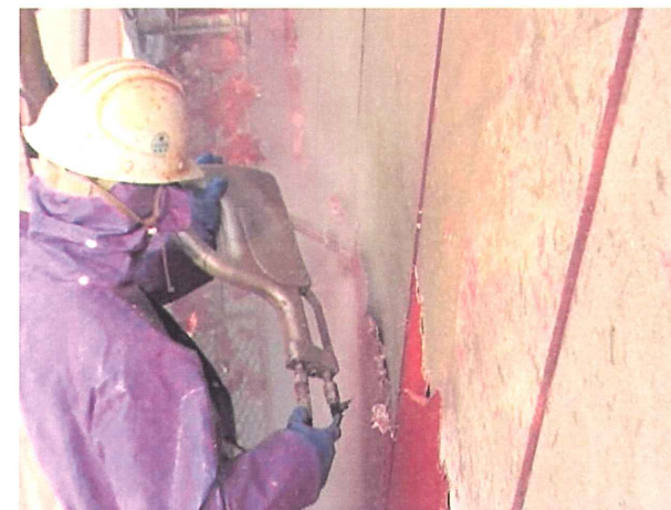
劣化塗膜の剥離や落書き落とし
