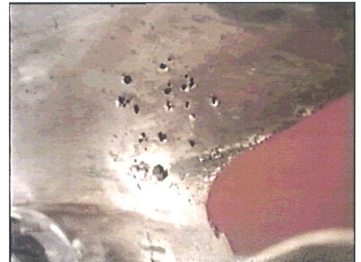
キャビテーションによる壊食
