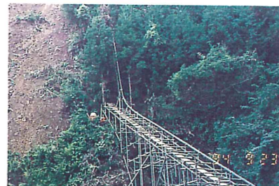
▲支持台利用方式(一部)(高架工法…単管足場パイプの上に設置)
